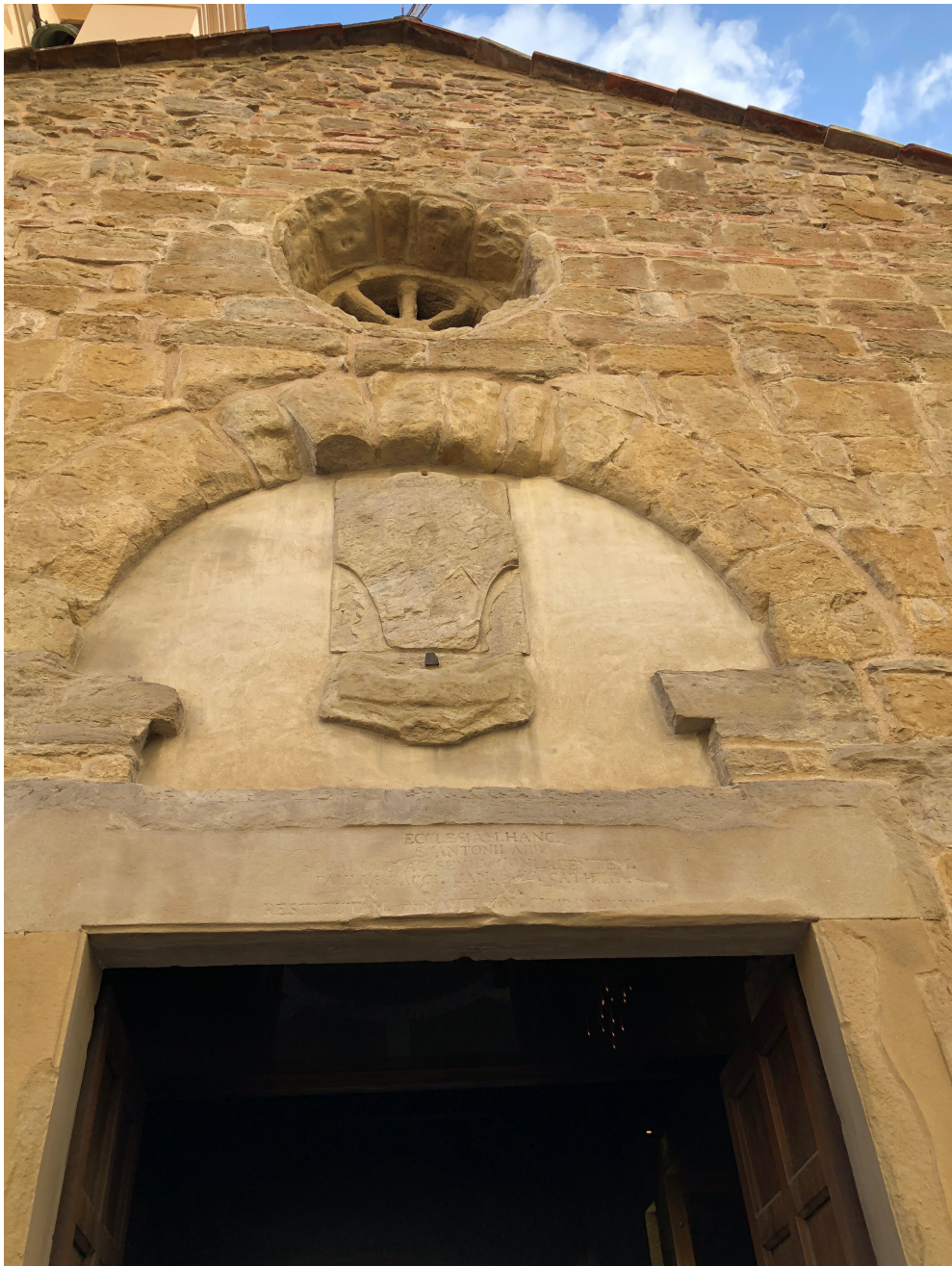
Particolare della facciata in evidenza il portale e il rosone romanici sec. XII.
